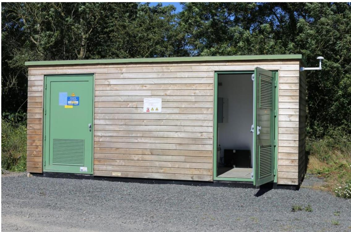
*Figure 174 : Exemple d'un poste de livraison habillé d'un bardage en bois (source : AEPE Gingko, 2018)*
